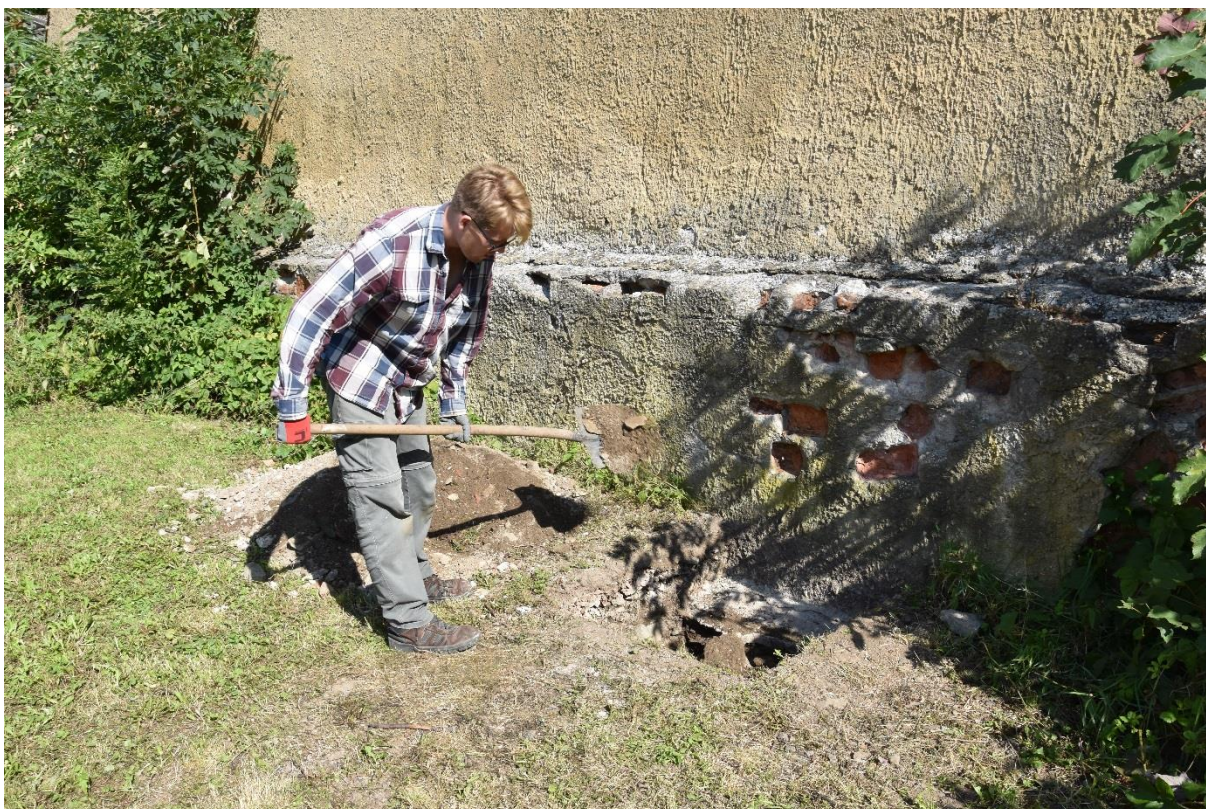
Obr. 25. Na závěr výzkumu nás čekalo zasypání sond a uvedení zkoumaných prostorů do původního stavu (foto M. Preusz)
